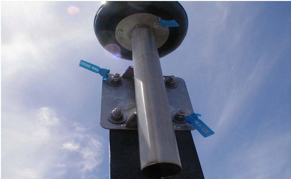
Vista de antena correctamente precintada con base de acero inoxidable
